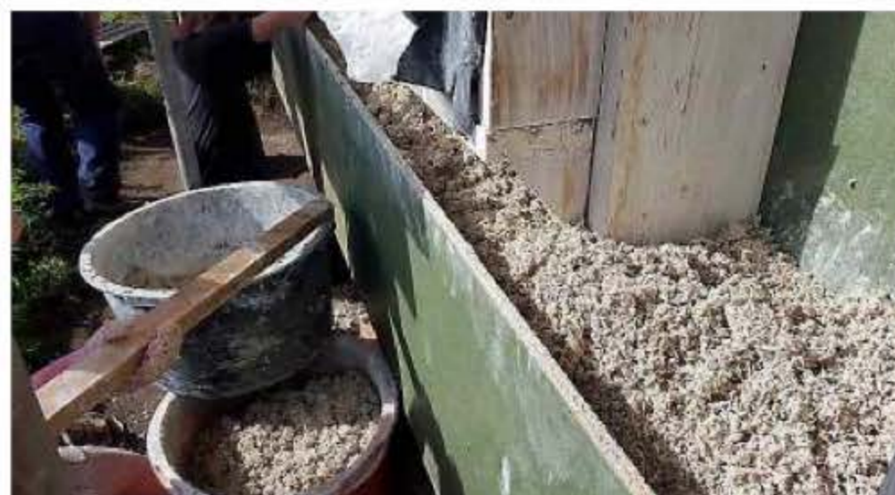
De muren worden opgetrokken uit snippers van hennepstengels en kalk.
